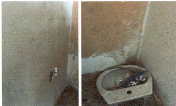
Foto 7: Sustitución de lavamanos en módulo 1 de aula.
