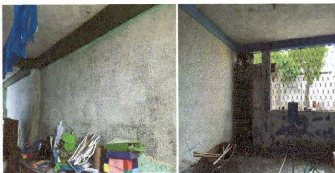
Foto 9: Alisado en muro en módulos 1 y 2 de aulas.
