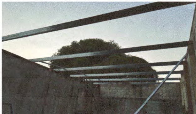
Foto 1: Sustrucción de lámina acanalada, por lámina troquelada aluzinc calibre 26 en módulo de aula y sustrucción de soporte de madera por metal.
