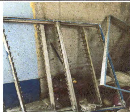
Foto 4: Sustrucción de ventanas de aluminio y vidrio de paletas por ventanas de pvc. Y vidrio corredizo en módulo de la dirección.
