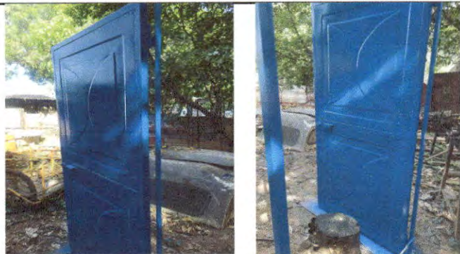
Foto 11: Fabricación e instalación de puertas de metal en módulos 1 y 2 de aulas.
