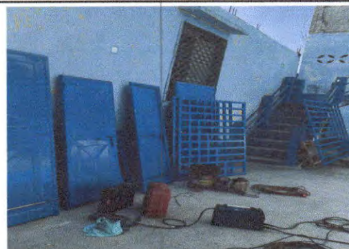
Foto 12: Fabricación e instalación de puertas de metal en baños en módulos 1 y 2 de aulas.
