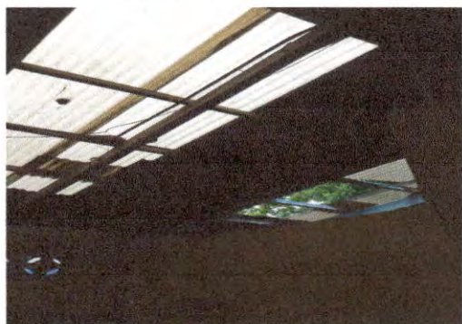
Foto 3: Sustrucción de lámina acanalada, por lámina troquelada aluzinc calibre 26 en módulo de baños.
