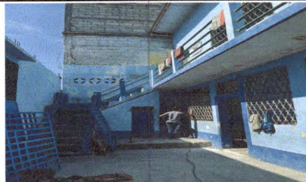
Foto 10: Fabricación e instalación de balcones de hierro en ventana en módulos 1 y 2 de aulas.
